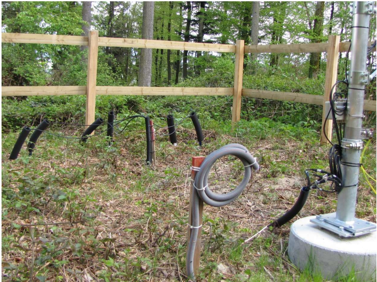
Abbildung 2: Messstation in Mühledorf mit erdverlegter Verkabelung.
